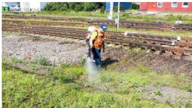
**Фото 2.** Обработка одно- и двулетних травянистых сорняков на железнодорожных путях Октябрьской железной дороги – филиала ОАО «РЖД», 2016 г.
