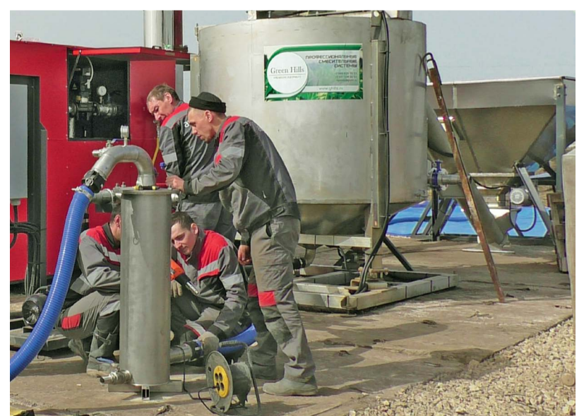
Монтаж установки для производства КАС и ЖКУ
