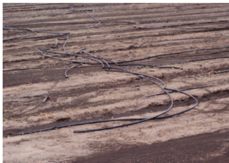
Трубка, смытая сильными ливнями при поверхностной укладке
