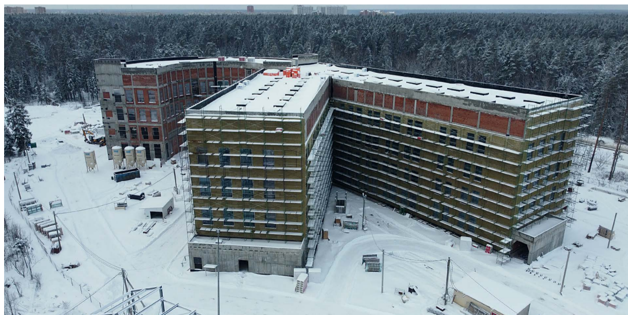
Строющийся научный центр «Августа» в Черноголовке. Декабрь 2023 года
