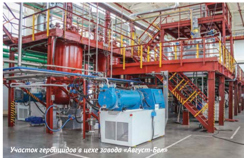
Основной производственный цех завода в Беларуси
