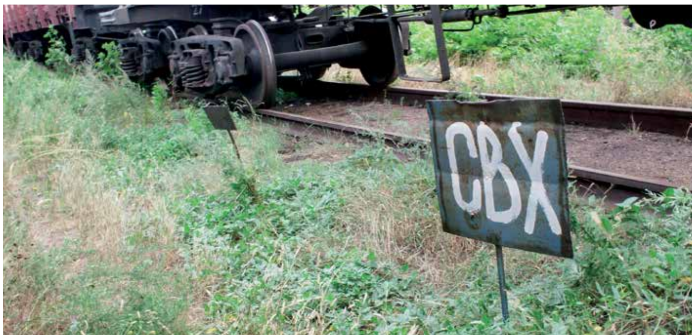
Фото 17. Перед обработкой (23 июля) баковой смесью Торнадо®, 6 л/га + Магнум®, 0,3 кг/га + Адьо®, 0,2 л/га. Станция Павлодар ГАЦ АО «Казахстан Темир Жолы», 2010 г.
