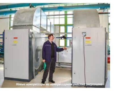
чтобы обеспечить их достаточным объемом сжатого воздуха, в 2013 году на компрессорном участке энергоцеха установили два новых винтовых маслозаполненных компрессора GA 75. Один из них укомплектован устройством, регулирующим объем производства сжатого воздуха в зависимости от потребности цеха, что позволяет экономить электрическую энергию.
