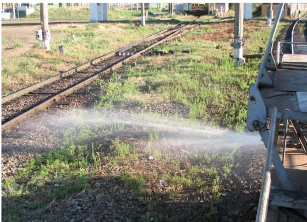
Фото 2 – Обработка пути и междупутья опрыскивающей установкой на железнодорожном ходу (02 июля 2009)
